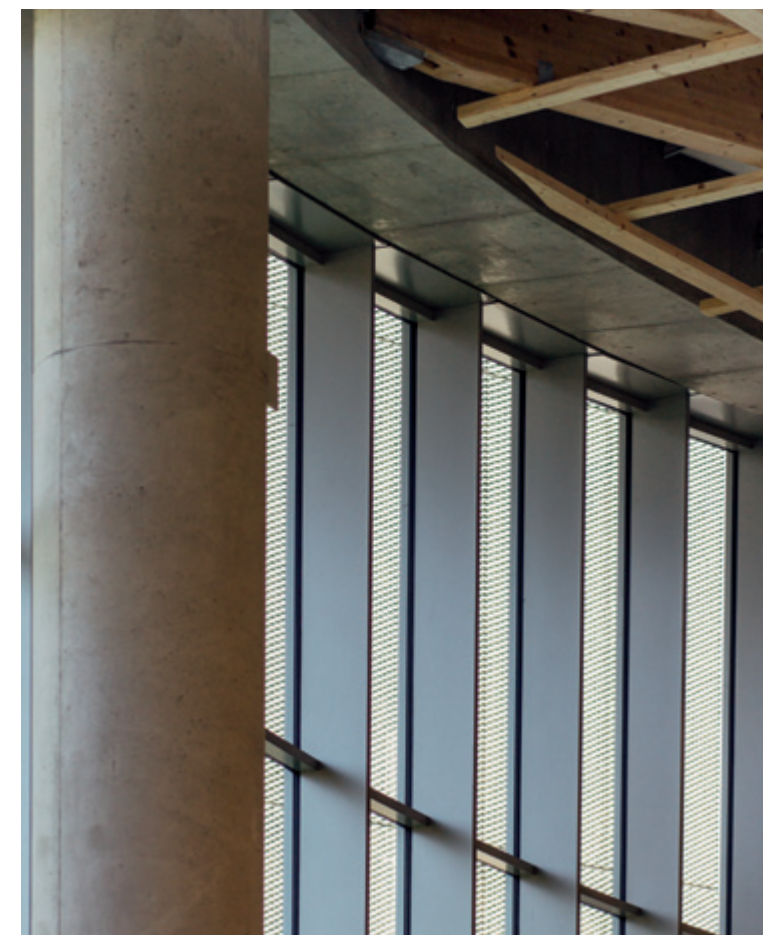
◀◀ „W hali basenowej, poniżej dźwigarów z drewna klejonego, zastosowaliśmy formę rusztu-struktury drewnianej, która jest elementem czysto ozdobnym”
